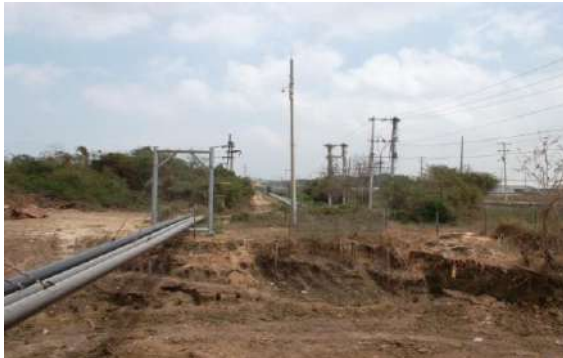
FOTO No 2 AREA DE LA ESTRUCTURA DE SOPORTE A REFORZAR
