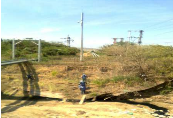
FOTO No 1 AREA DE LA ESTRUCTURA DE SOPORTE A REFORZAR.
