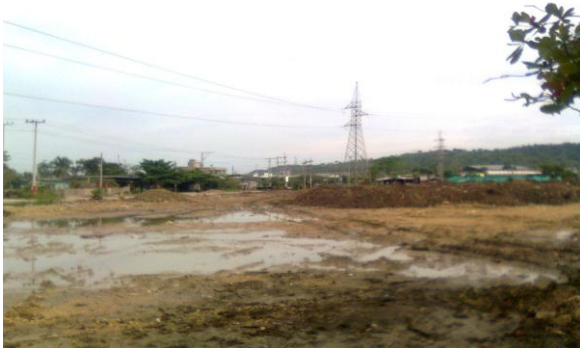
LOTE OBJETO DE TRABAJOS DE RELLENO
