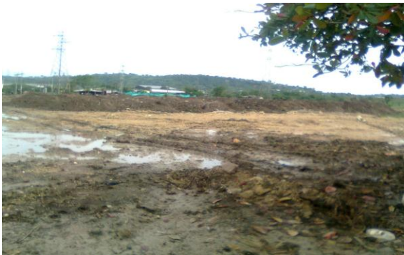
LOTE OBJETO DE TRABAJOS DE RELLENO
