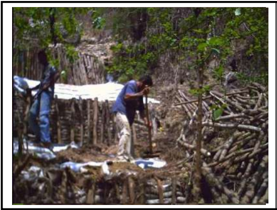
Adecuación de sacos
