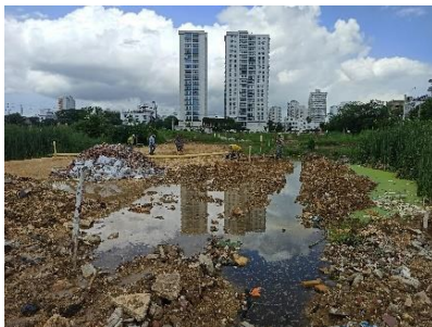
Figura 6. Relleno cuerpo de agua con RCD, residuos ordinarios y zorra y desecación del mismo. a) Lugar de origen del agua succionada con sistema utilizado; b) lugar de destino del agua captada.
