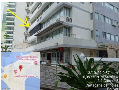
Fachada Edificio Faro Tequendama reparaciones locativas en apartamento 301.
