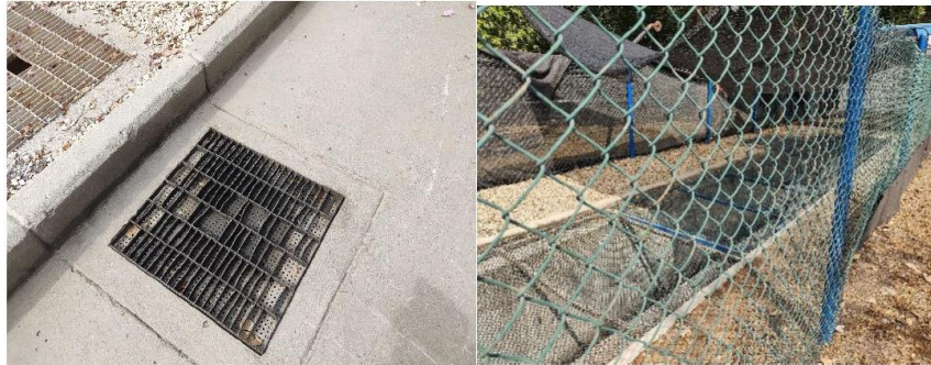
Rejillas para agua lluvia y separador API para ARnD.
