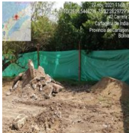
Imagen 3. Desarrollo de la visita, se evidencia RCD tipo demolición.
