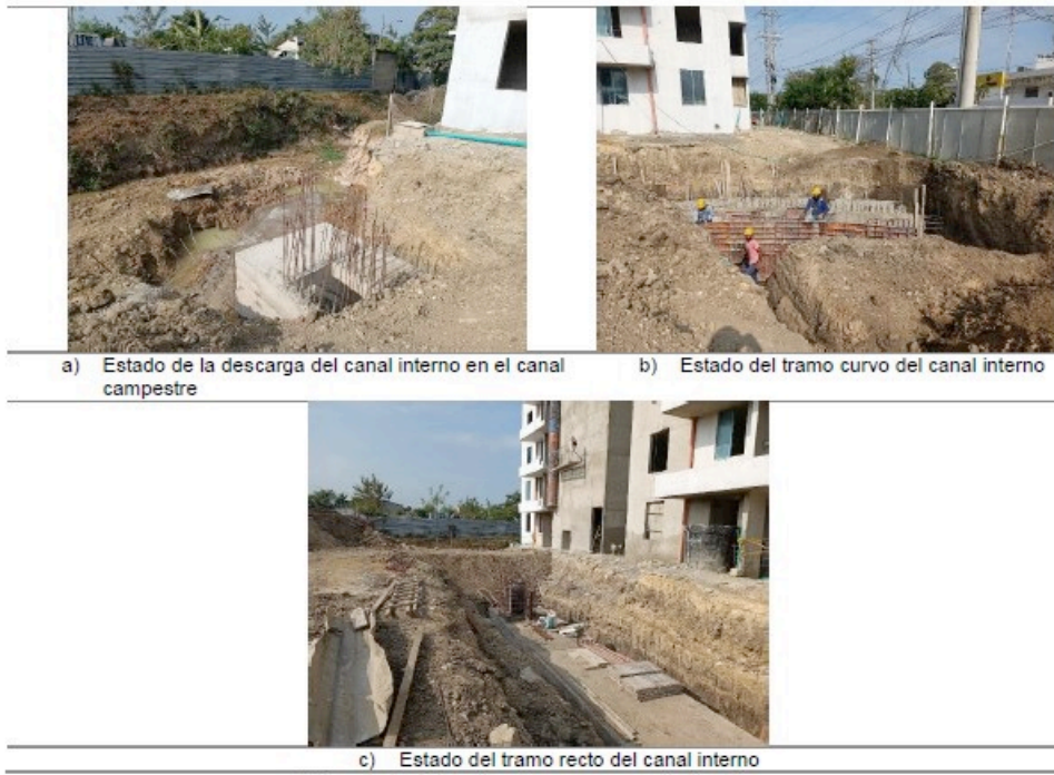
Figura 3. Estado de avances de la obra
