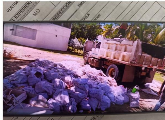
Volqueta que transportó los RCD el 10/10/2022, aportado por el generador
