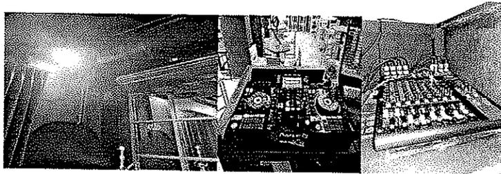
*5 cabinas activas electro voice ekx 15p, 1 bajos electro voice ekx, instaladas en las esquinas superiores del establecimiento a la altura del techo, en la parte superior de la barra, en la esquina izquierda a la altura del techo cerca a la puerta de salida, el bajo se encuentra a un lado de la cabina del Dj.*
