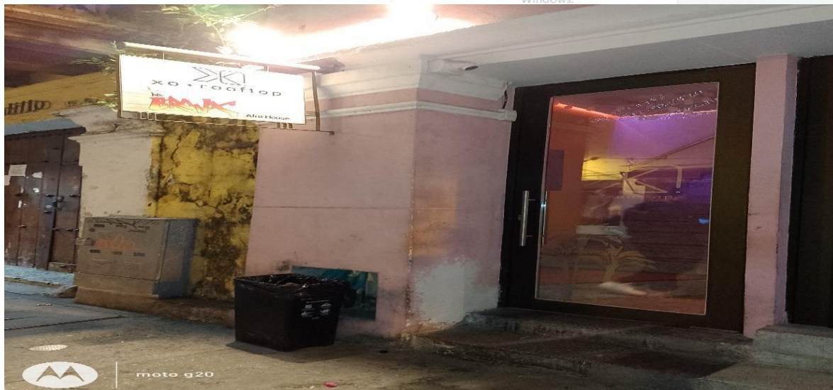
Entrada principal por la cual se sube al segundo piso donde se encuentra ubicada la discoteca, cuenta una puerta con marco de aluminio referencia 3x1. ½ con adaptador y vidrios termo acústicos DVH 19. Templado de 5mm inc/ cámara de aire ermitica de 9/ templado 5mm inc.
