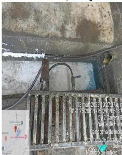
**Figura 4. Rejilla contaminada con restos de pintura**
