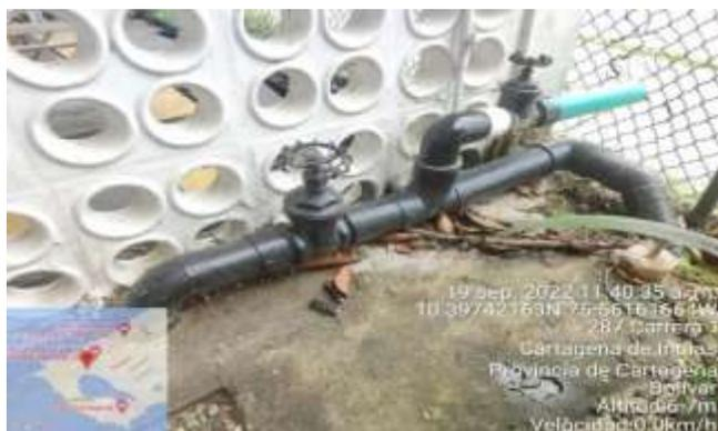
**Ilustración 5. Válvulas de Conexión de aguas lluvias al alcantarillado y válvula de emergencia a la vía pública.**
