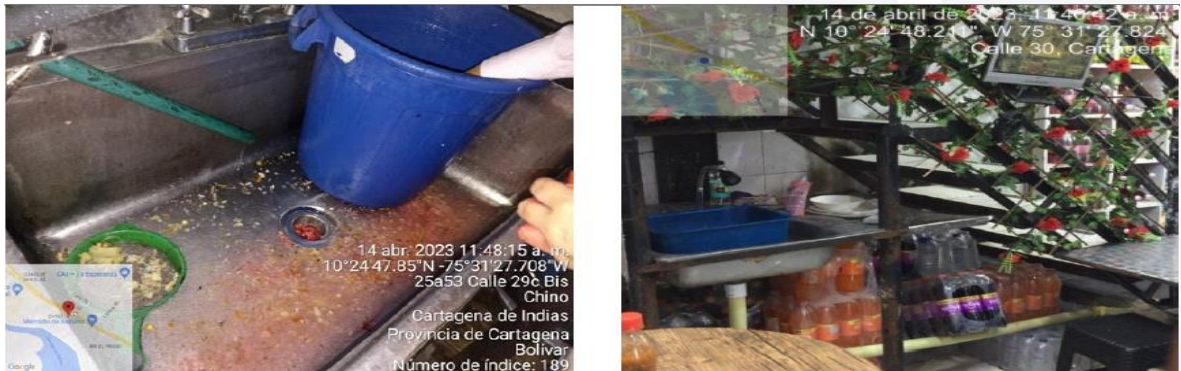
Figura 2. Conexión de tuberías a drenajes pluviales
