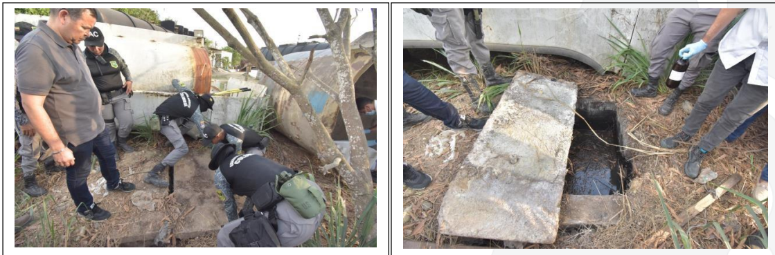
Imagen 3. Registro cubierto con tapas de concreto y material vegetal seco. Fuente EPA Cartagena.
