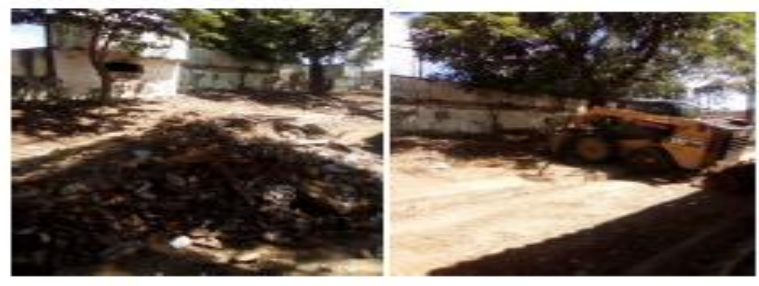
Zona verde encerrada, que la comunidad quiere recuperar, para que no siga como parqueadero.
