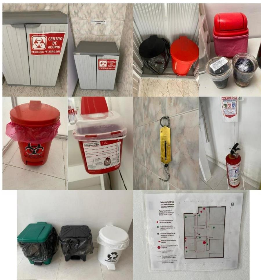
**Ilustración 1: Almacenamiento Temporal de Residuos Peligrosos, ordinarios y reciclables, guardián, báscula, extintores y ruta de evacuación de residuos.**
