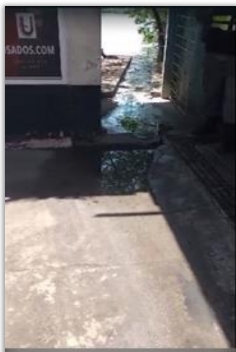
ANTES DEL MURO DE CONTENCIÓN
