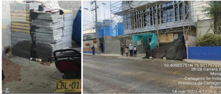
Figura 2. Lugar del vertimiento - Edificio DATACENTER Fuente: Autores 2023
