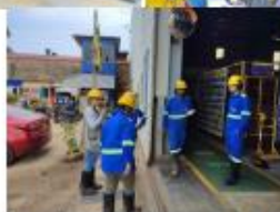
Área de figurado de las vanillas fabricadas en la planta de DIACO Cundinamarca.
