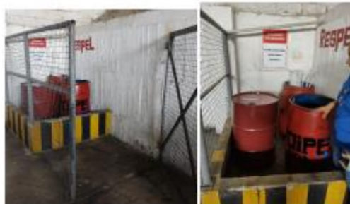
Almacenamiento temporal de residuos peligrosos.
