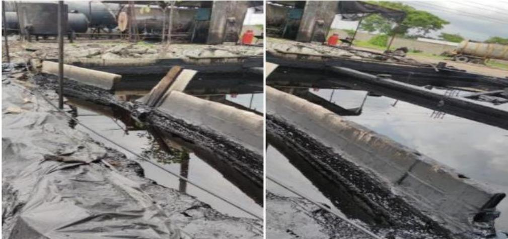
**Figura 6.** Muro de contención caídos no cumpliendo con su finalidad y evidenciando un clarderrame al suelo de sustancias oleosa.
