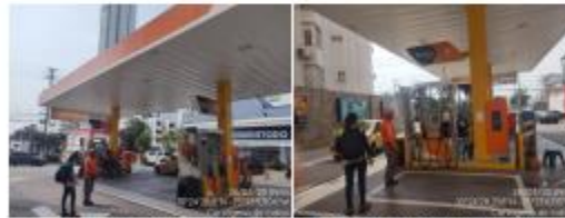
Figura 3. Islas y Surtidores de distribución de combustibles - EDS LA SAN MARTIN Fuente: Propia
