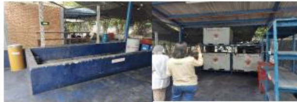
Almacenamiento temporal de residuos peligrosos.
