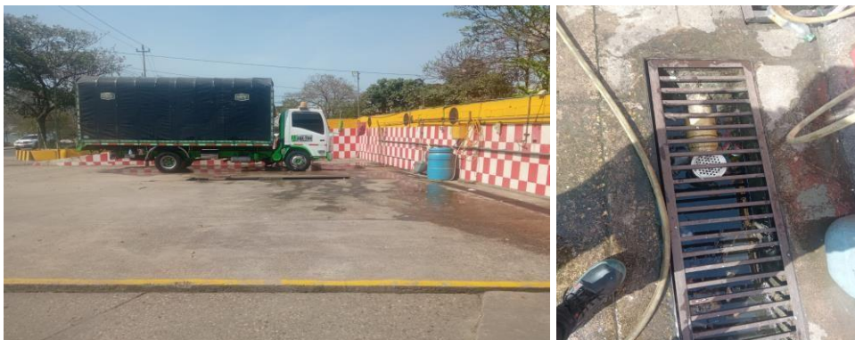
Imágenes 2 - 3. Zona de lavado - Trampa de grasas
