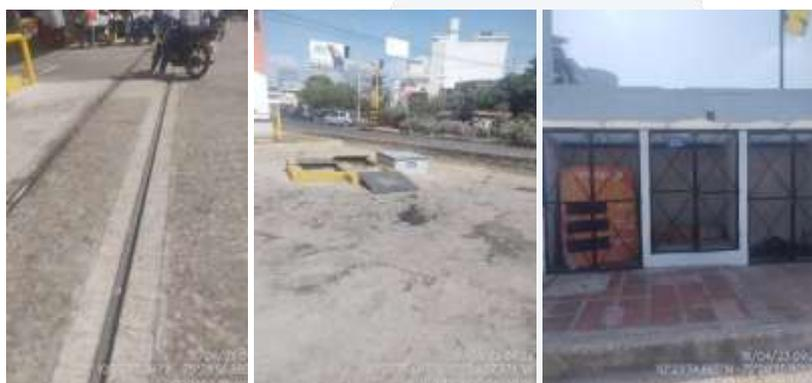
**Figura 4. (a) Rejillas perimetrales. (b) Sistema de trampas de grasas y sedimentadores. (c) Zona de almacenamiento de RESPEL - EDS COESCO EL AMPARO**
