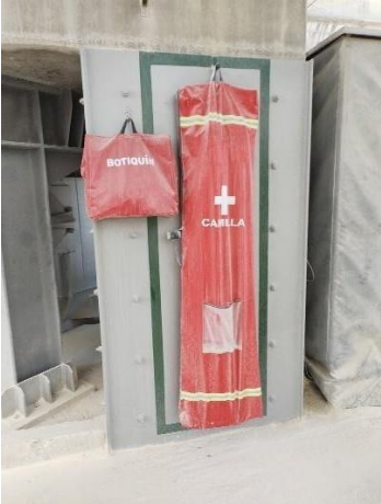
Equipos para atender emergencias y contingencias en el área de operaciones.
