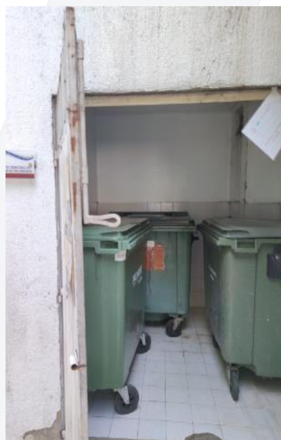
Ilustración 4. Depósito de almacenamiento
