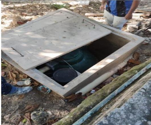
Ilustración 1. Trampa de grasa a la salida del vertimiento
