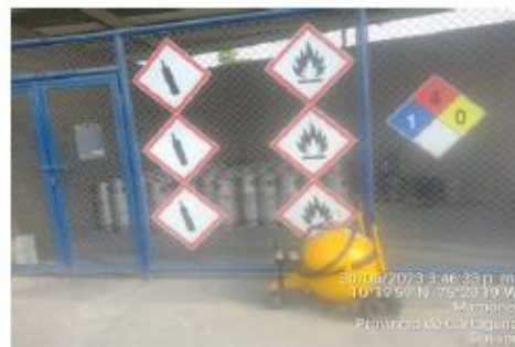
Cuarto almacenamiento de gas.
