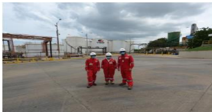
Area operativa y tanques de almacenamiento.
