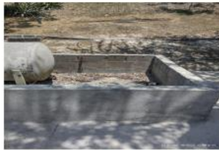
Dique donde se instalará el tanque de almacenamiento de ACPM
