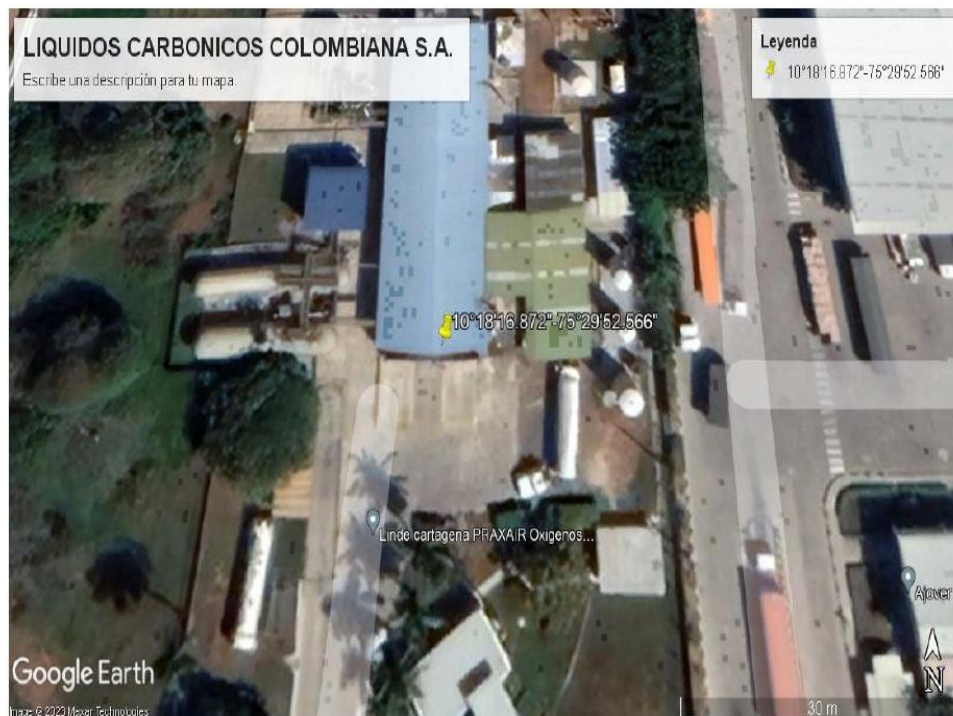
Imagen 11. Localización líquidos carbonicos colombiana S.A. Fuente: Google Earth, 2023
