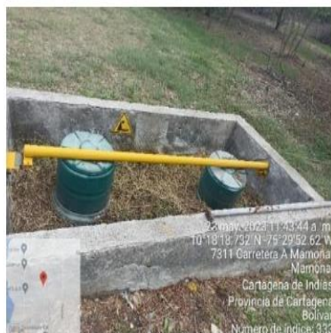
Imagen 7. Poza séptica zona vestir
