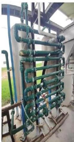
Ilustración 11. Tanque de coagulación y floculación.
