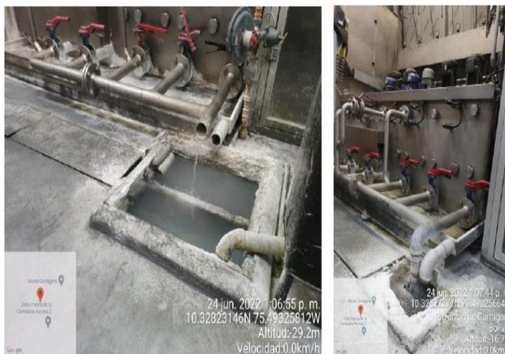
*Ilustración 1. Puntos de descarga de lavadoras del proceso de fabricación de envases de aluminio.*
