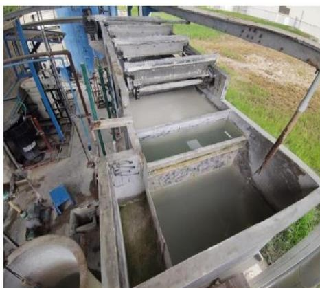
Ilustración 16. Tanque DAF
