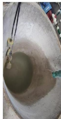
Ilustración 13. Tanque de agua clarificada proveniente del DAF en el sistema fisicoquímico.
