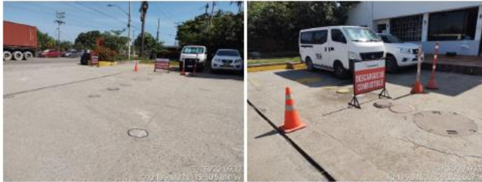
Figura 2. Tanques de almacenamiento de combustibles - EDS MAMONAL Fuente: Propia
