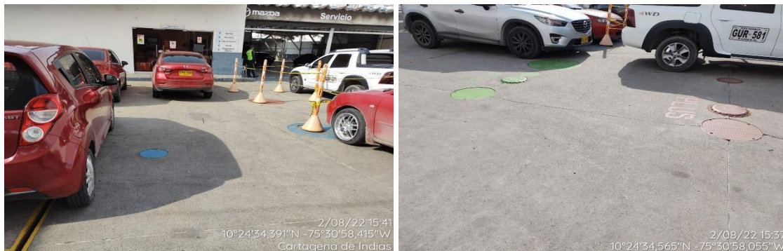
Figura 2. Tanques de almacenamiento de combustibles - EDS AUTOBOL Fuente: Propia
