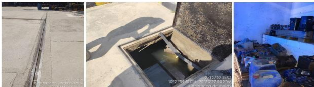
Figura 4. (a) Rejillas perimetrales. (b) Sistema de trampas de grasas y sedimentadores. (c) Sitio de almacenamiento RESPEL- EDS VICPIMAR Fuente: Propia
