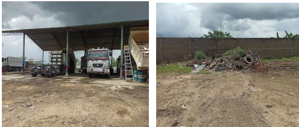
Figura 4. zona de taller: a) no se observa sistema de retención perimetral; b) Acumulación inadecuada de residuos sólidos
