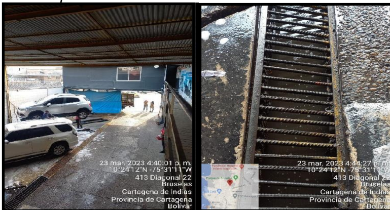
Imágenes 2 - 3. Zona de lavado - Trampa de grasas
