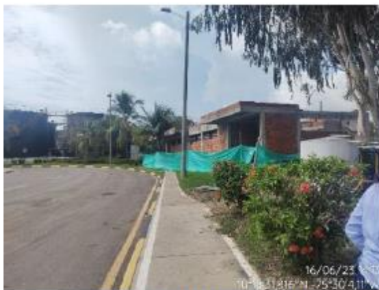
Construcción de Lockers Trabajadores
