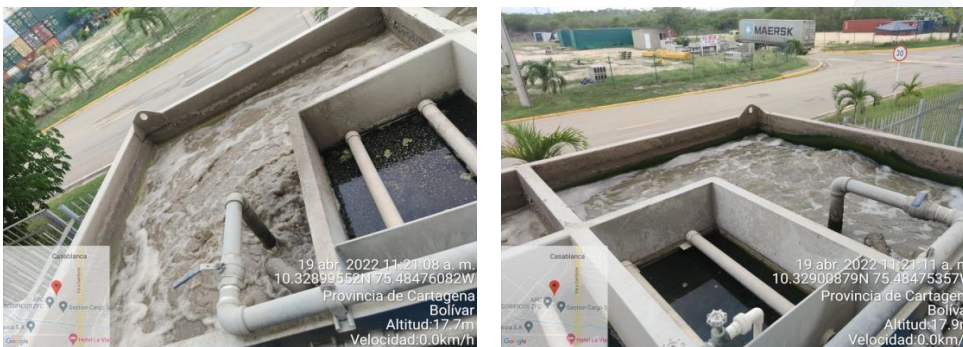
Ilustración 2. Tanques de lodos activados
