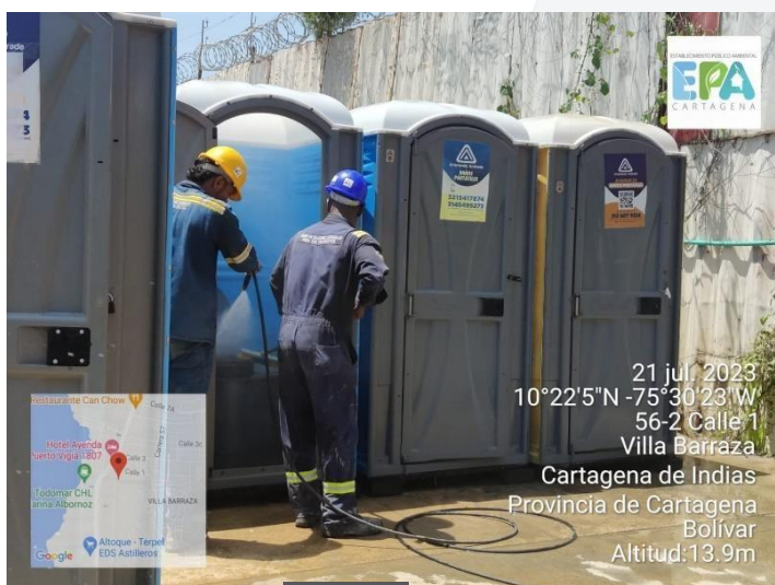
Ilustración 2. Zona de lavado de cabinas
