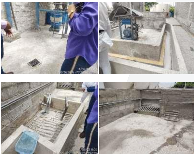
Figura 4. Visitas de inspección a modificaciones realizadas al sistema de tratamiento (4.09.23)
