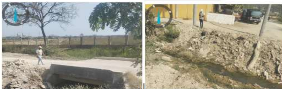
Imagen 2. Visita de Inspección Boxcloulvert 1
