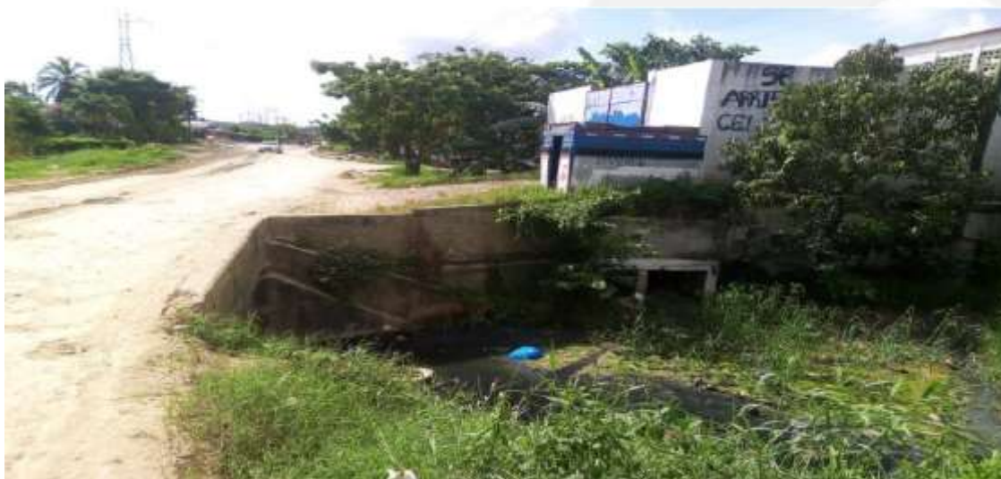
Imagen 8. Canal localizado en costado izquierdo de la vía. Fuente: Elaboración propia (SID 2021).
