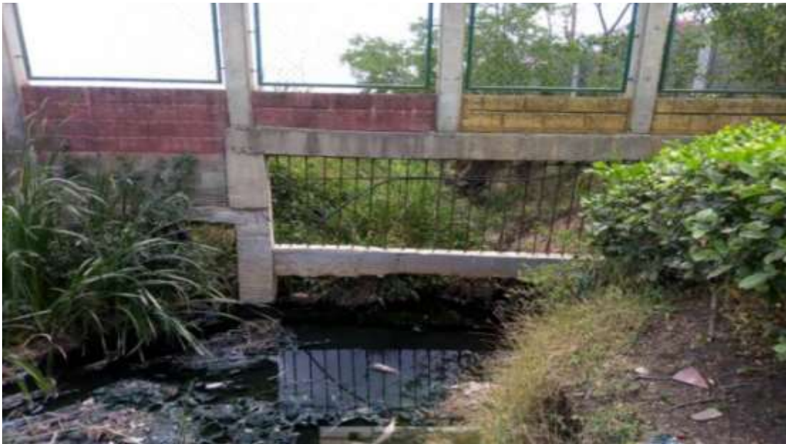
Imagen 9. Canal localizado en costado derecho de la vía. Fuente: Elaboración propia (SID 2021).
