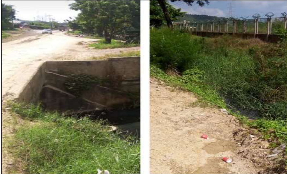
Imagen 10. Canal localizado en costado derecho de la vía. Fuente: SID 2021.
