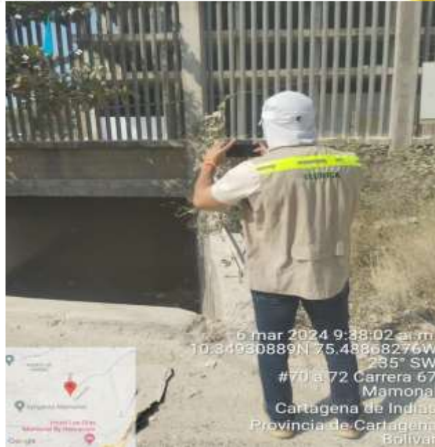
Imagen 2. Visita de Inspección Boxculvert 2
