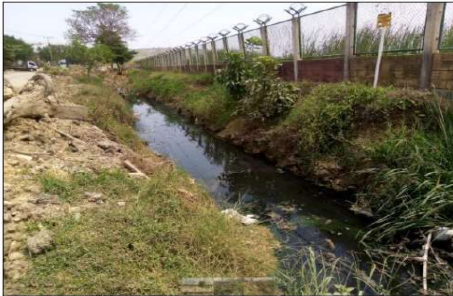
Imagen 7. Canal localizado en costado derecho de la vía. Fuente: Elaboración propia (SID 2021).
