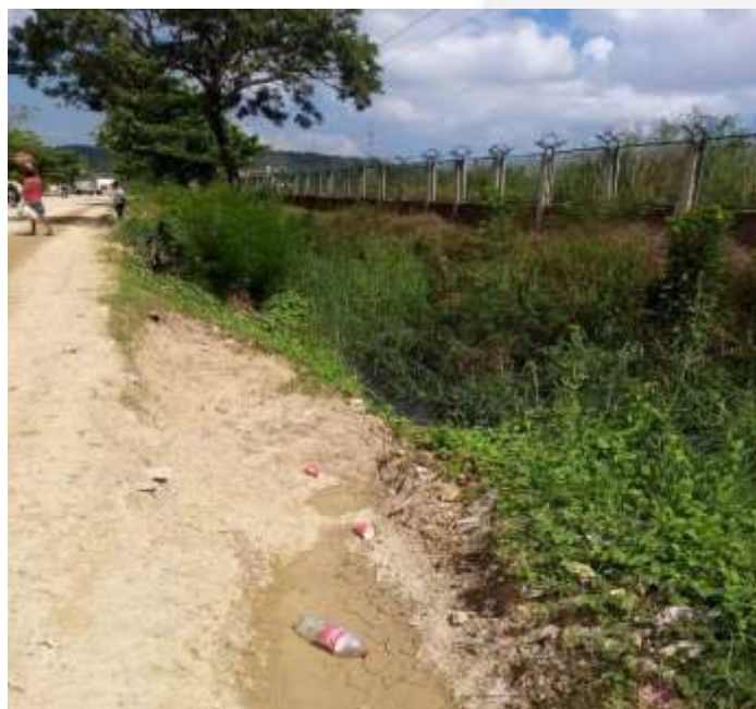
Imagen 9. Canal localizado en costado derecho de la vía. Fuente: Elaboración propia (SID 2021).
