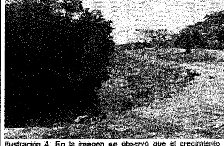
Ilustración 4. En la imagen se observó que el crecimiento del mangle se desarrolló en el centro del canal lo que impide el flujo del agua. Fuente de foto: funcionario EPA.
