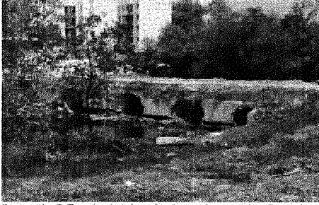
Ilustración 5. Puente de tubos donde se observan las dimensiones por donde para el flujo del agua. Fuente de foto: funcionario EPA.
