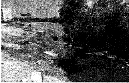
Ilustración 3. En la imagen se observó que el crecimiento del mangle se desarrolló en el centro del canal lo que impide el flujo del agua. Fuente de foto: funcionario EPA.
