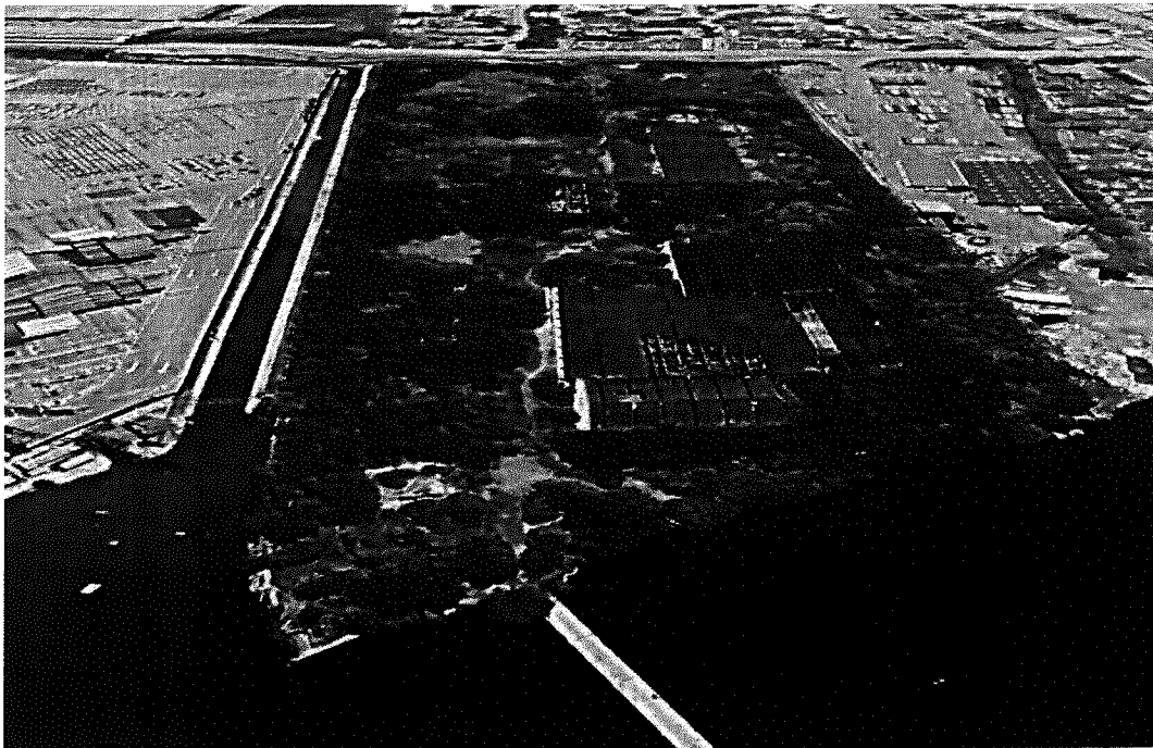
Fuente: TERMINAL DE CONTENEDORES DE CARTAGENA- CONTECAR-, 2024
