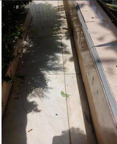
Figura 2. En la foto no se observan señales de agrietamiento de baldosas como tampoco de daños a la estructura causado por las raíces. Fuente de foto: Técnico Contratista.
