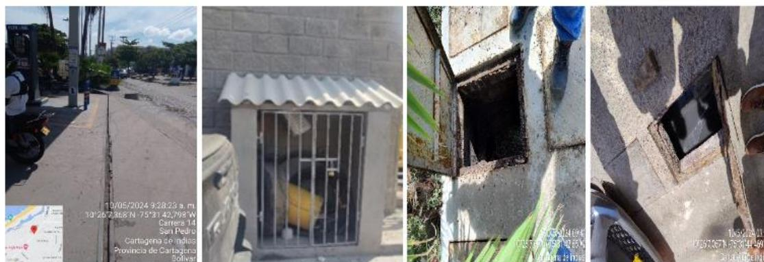
**Figura 4. (a) Rejillas perimetrales. (b) Sitio de Acopio de RESPEL(c y d) Sistema de trampas de grasas y sedimentadores. Zona 1 y 2. - EDS SS TORICES**
