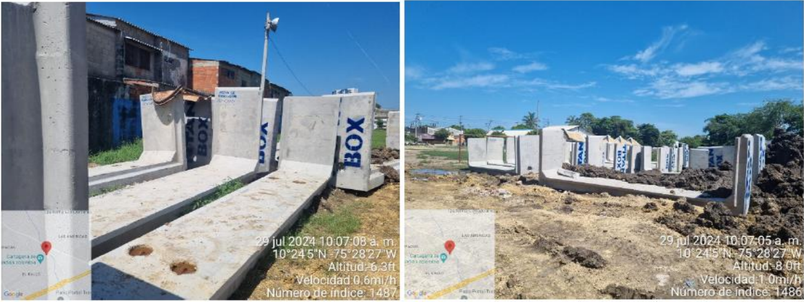
Ilustración 4. Acopio en el sitio de la obra de Box prefabricados por TITAN.
