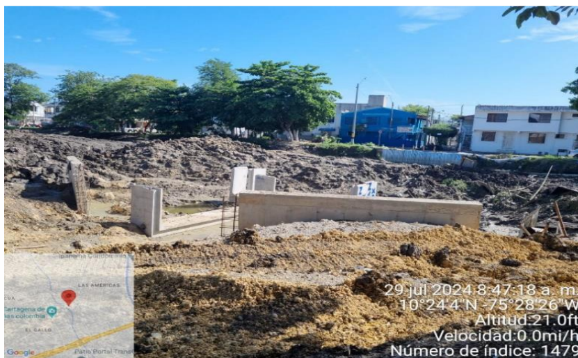
a) área de trabajo en seco
